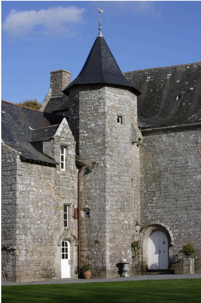
Logis. Détail de la tour d'escalier.
