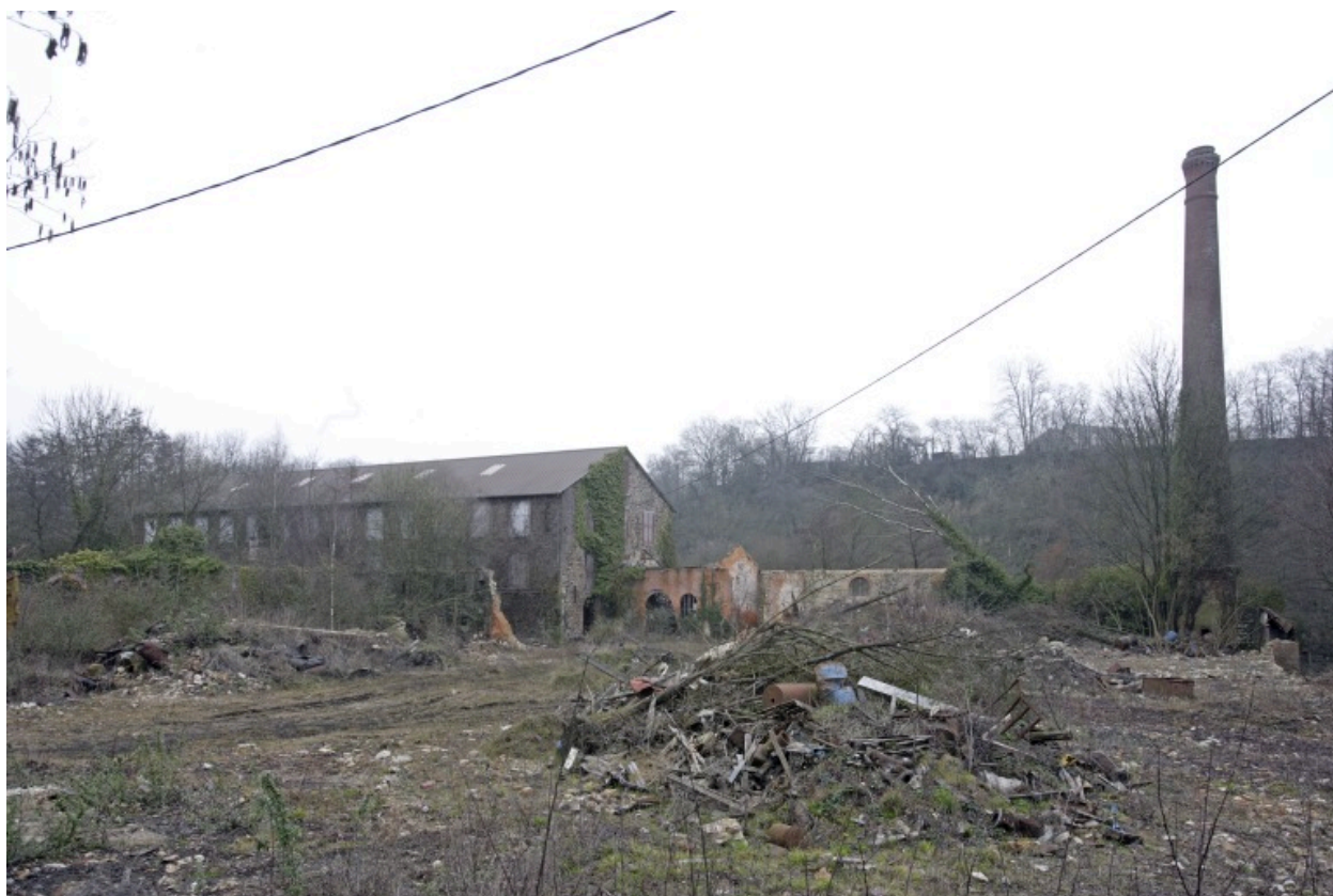
La filature et la cheminée vues depuis l'ouest.
