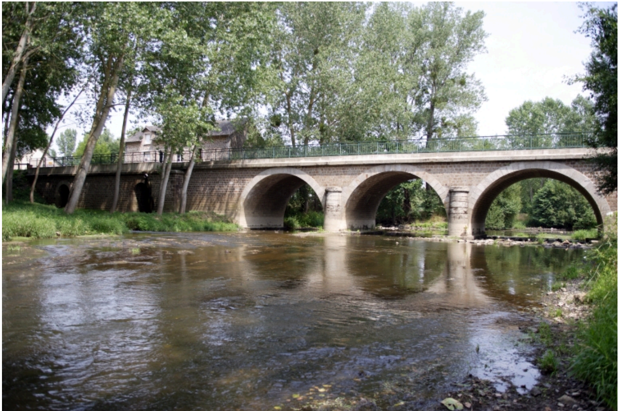
Vue d'aval, depuis la rive gauche.
