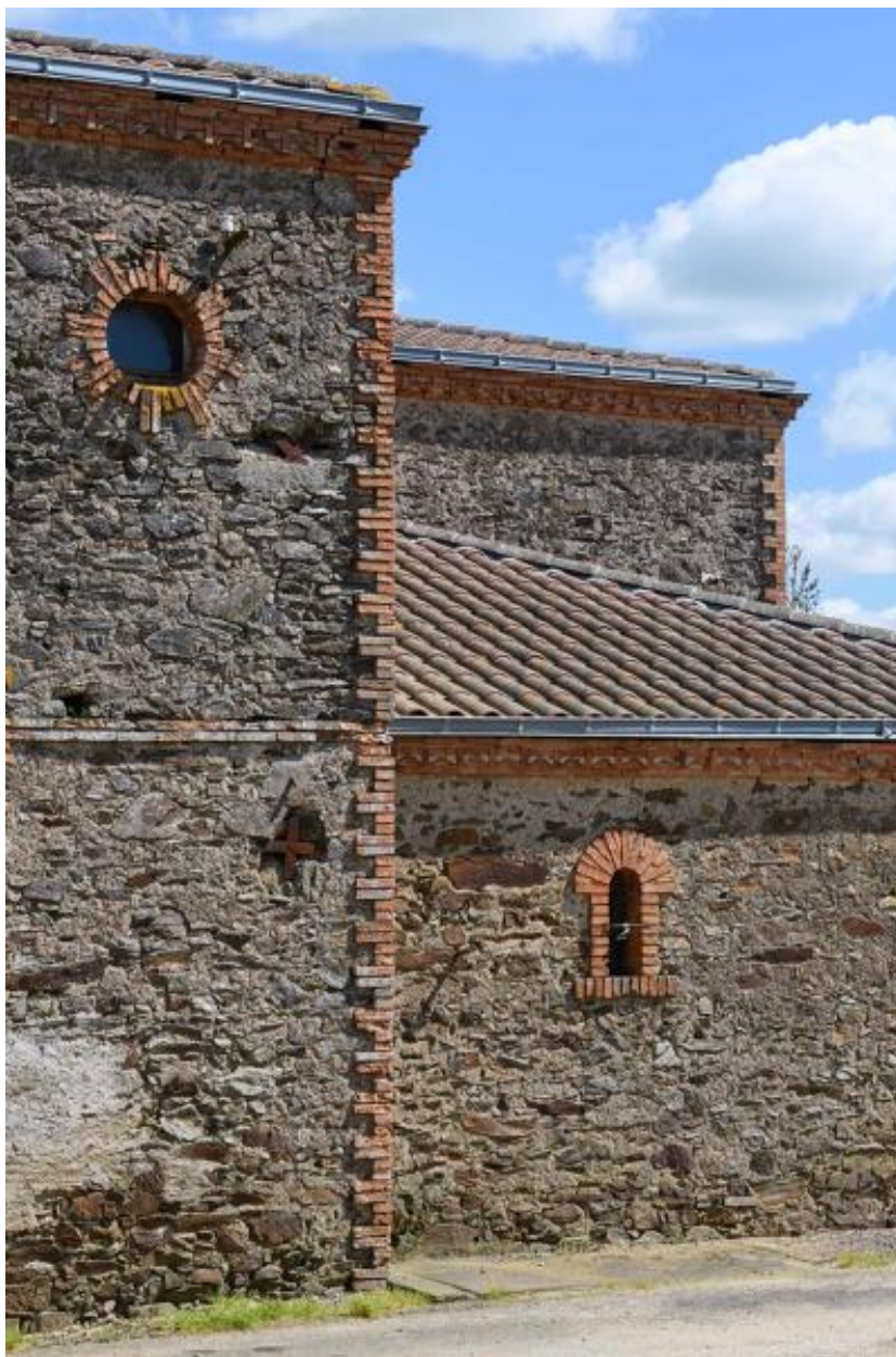
Façade ouest. Vue de l'angle sud de la grange et de la seconde écurie.
