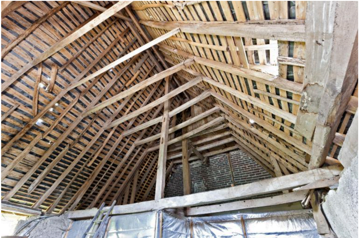
Comble : charpente côté ouest.
