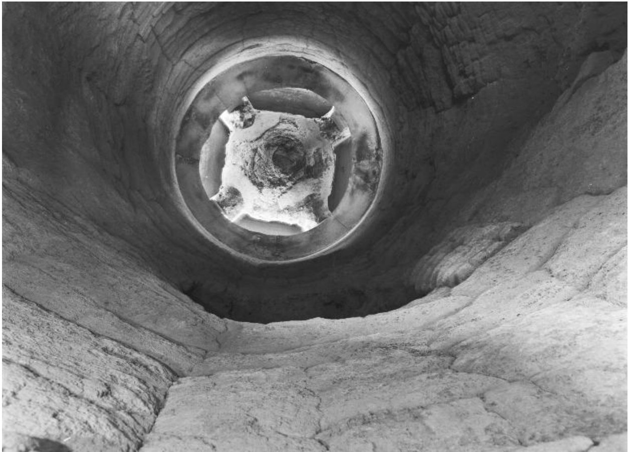
Usine de chaux, vue intérieure de la cuve d'un des fours vers la sole
