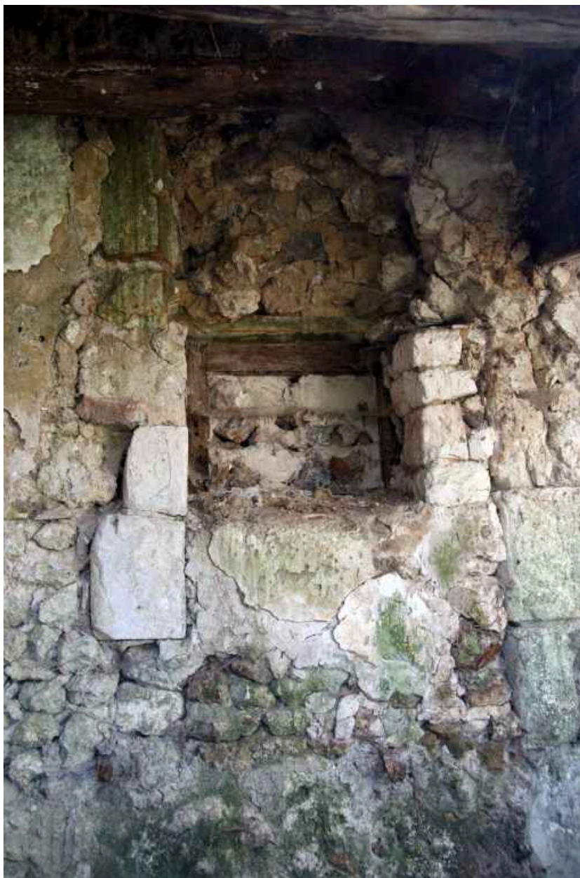
Maison n°2, façade postérieure, demie baie côté intérieur.
