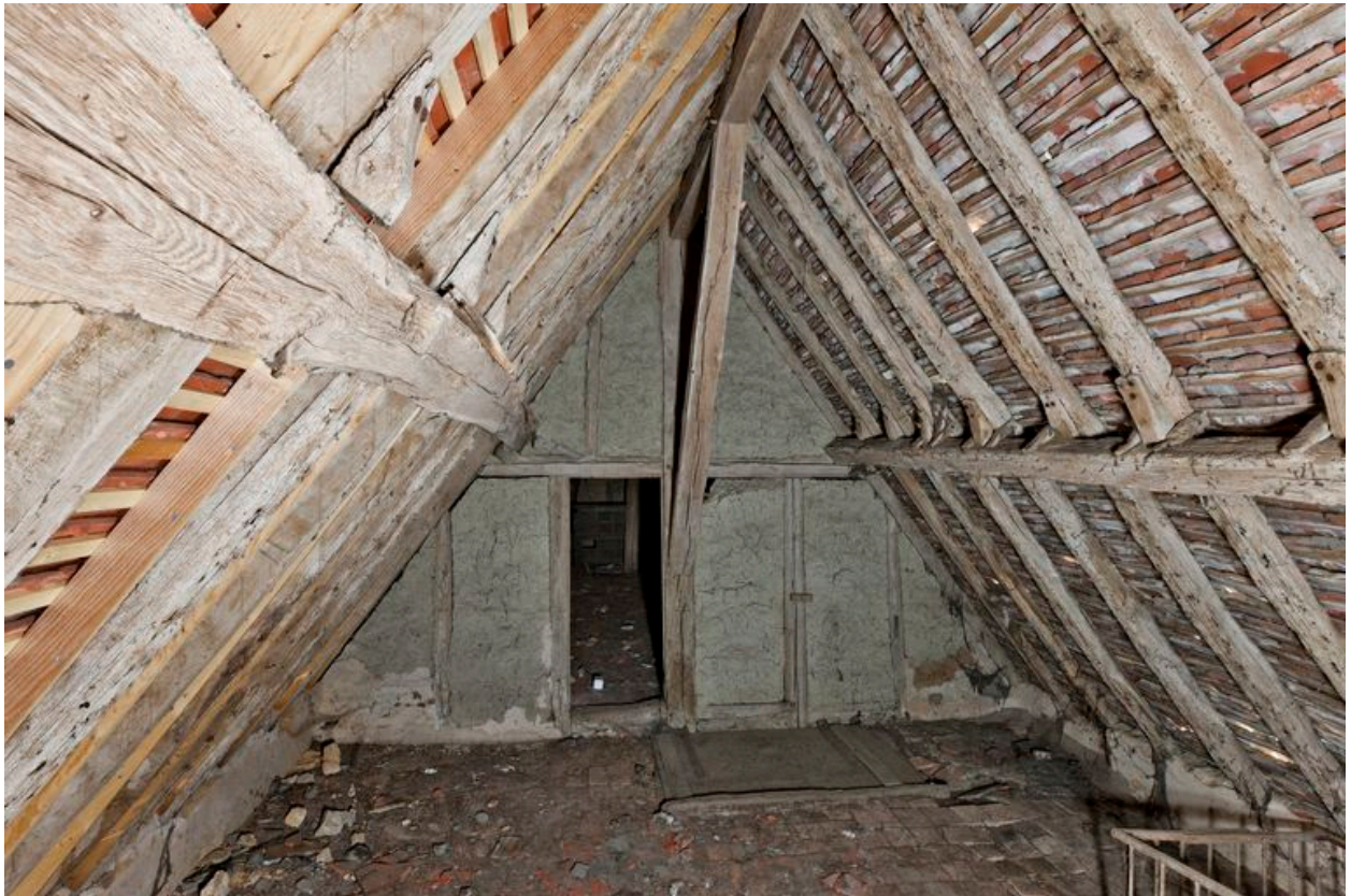
Vue de la charpente de comble du logis
