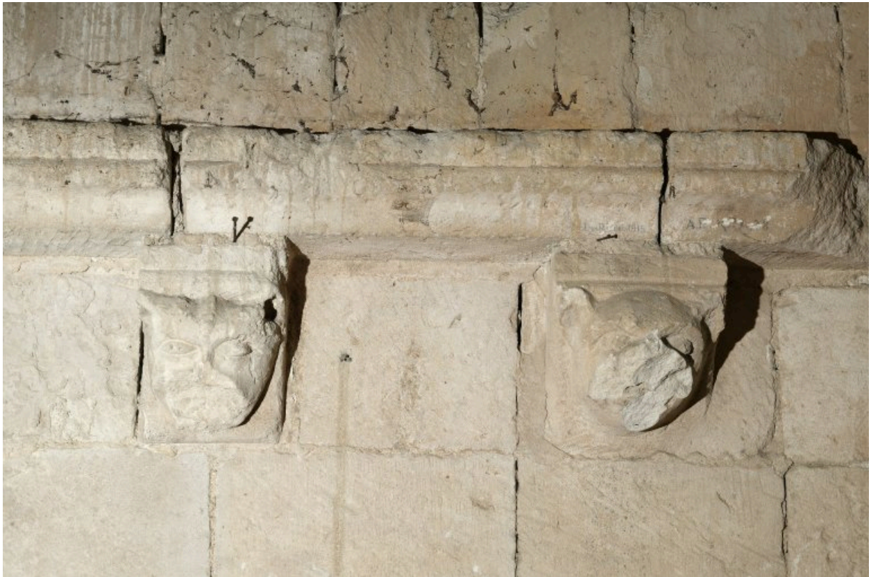
Chapelle orientée du bras sud du transept : modillons romans du côté extérieur du mur est, pris des combles de la sacristie.
