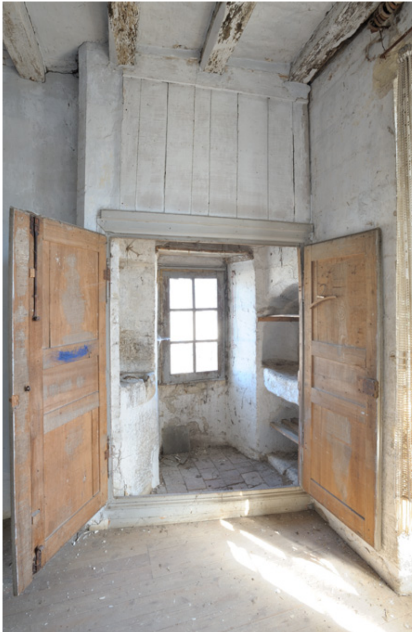
Etage, salle nord. Cabinet nord, baie et pierre d'évier.
