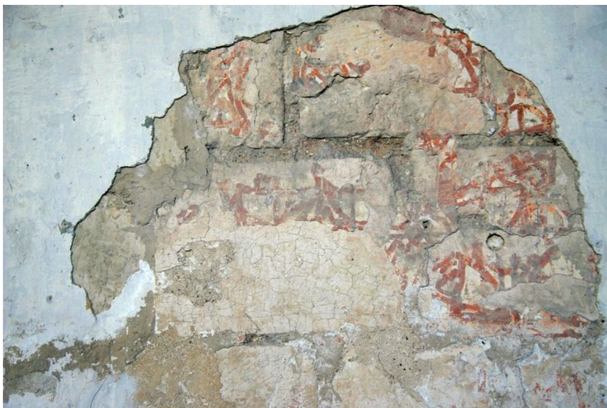
La nef, mur sud : taces d'un décor peint.
