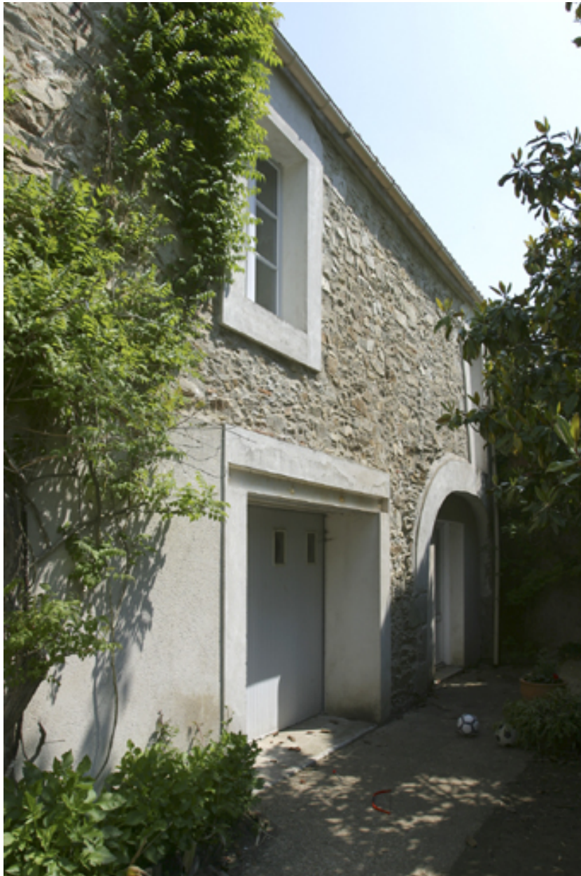
La façade postérieure du corps de bâtiment adressé n° 48 quai Chassagne.
