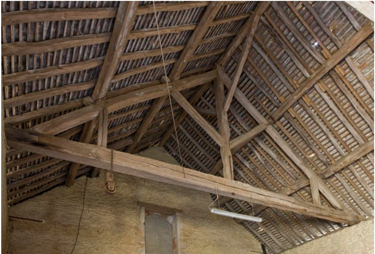
Ferme de charpente gauche de la charpente de la grange.
