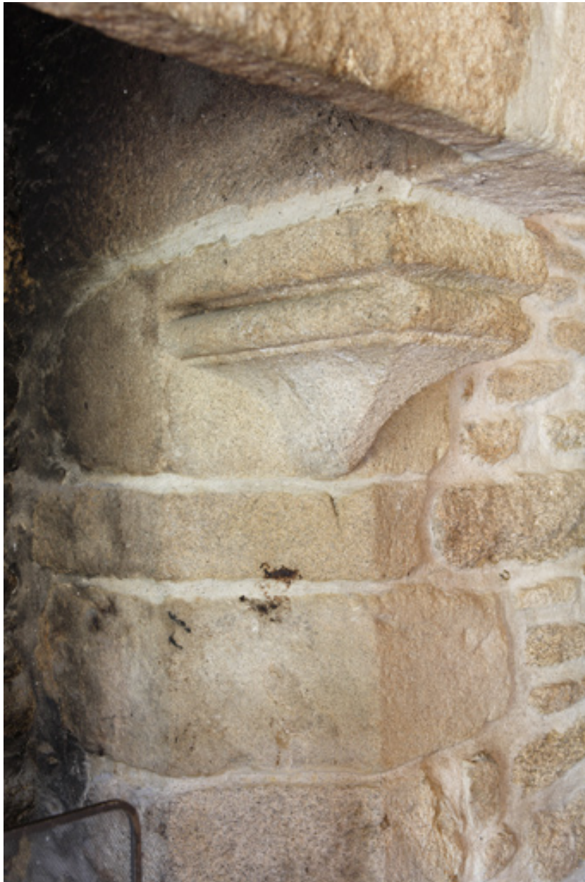
Logis. Cheminée du rez-de-chaussée. Détail de la console de droite.
