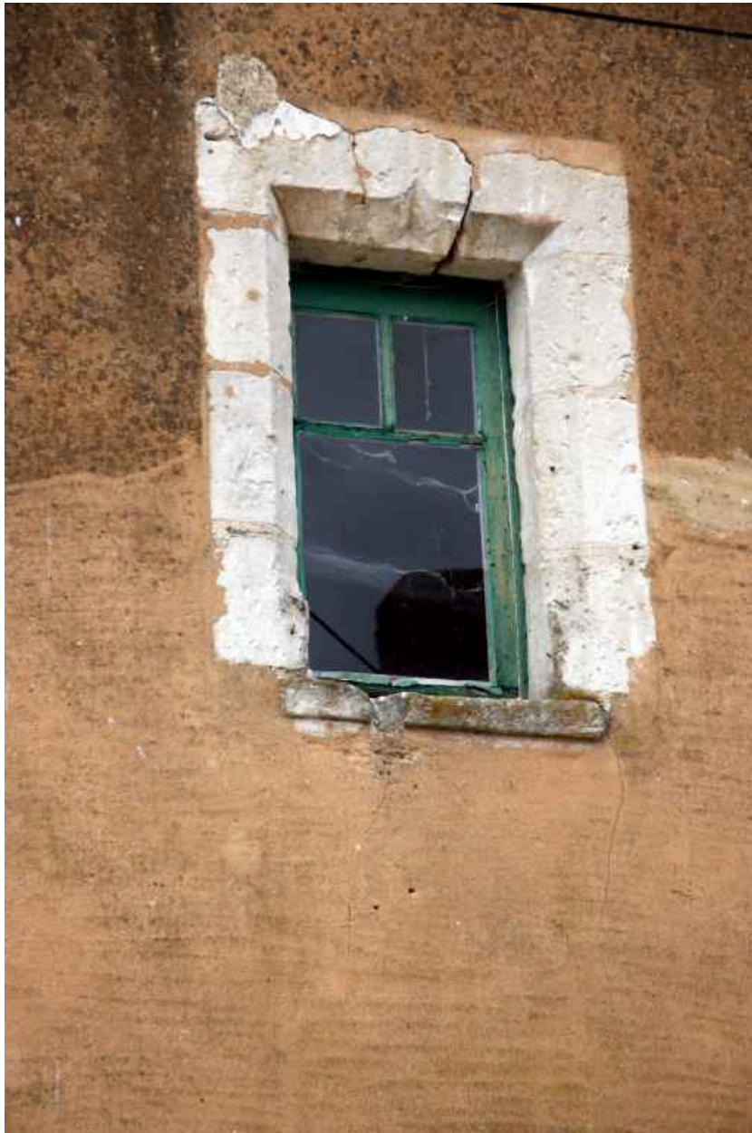
Baie chanfreinée dans le pignon.
