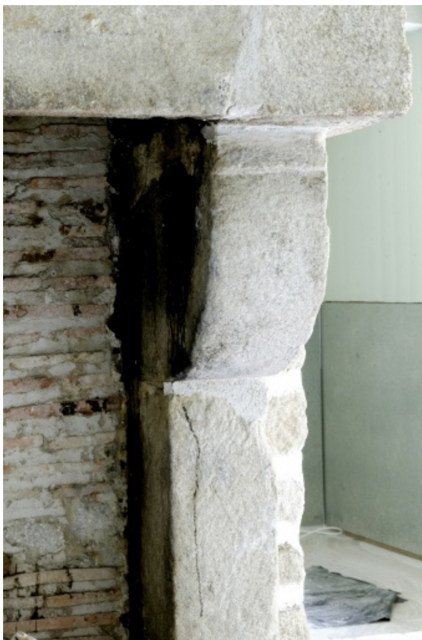
Cheminée au premier étage du bâtiment accolé.
