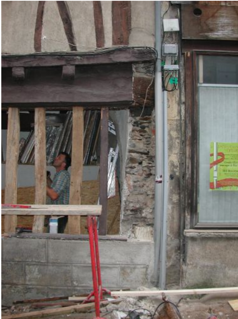
Boutique, partie droite après suppression du poteau-cornier, pendant les travaux d'octobre 2002.
