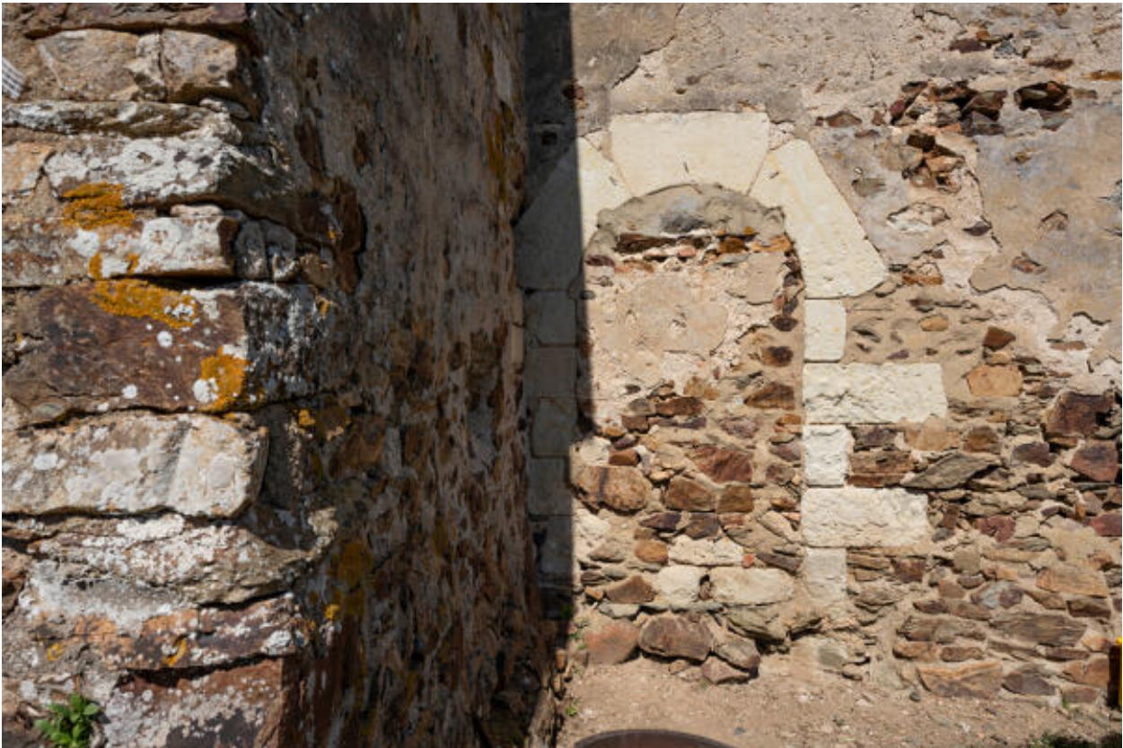
La porte murée de la façade latérale sud du logis.
