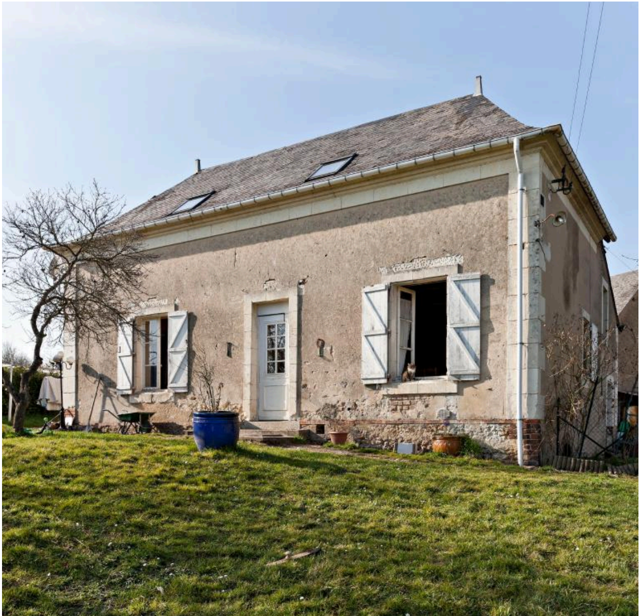
Maison, façade antérieure.
