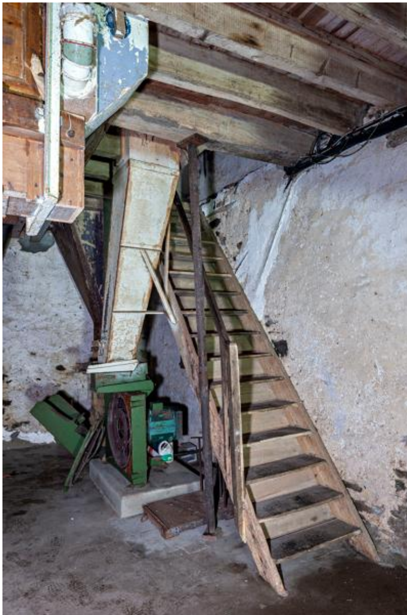
Rez-de-chaussée, partie sud-ouest : l'escalier et le broyeur à marteau utilisé pour l'orge (marque PROMIL, type B4C, N° 9252, date : 27/9/71).
