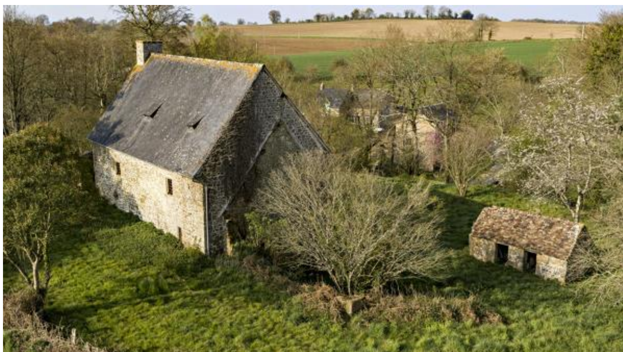
Vue aérienne du manoir.
