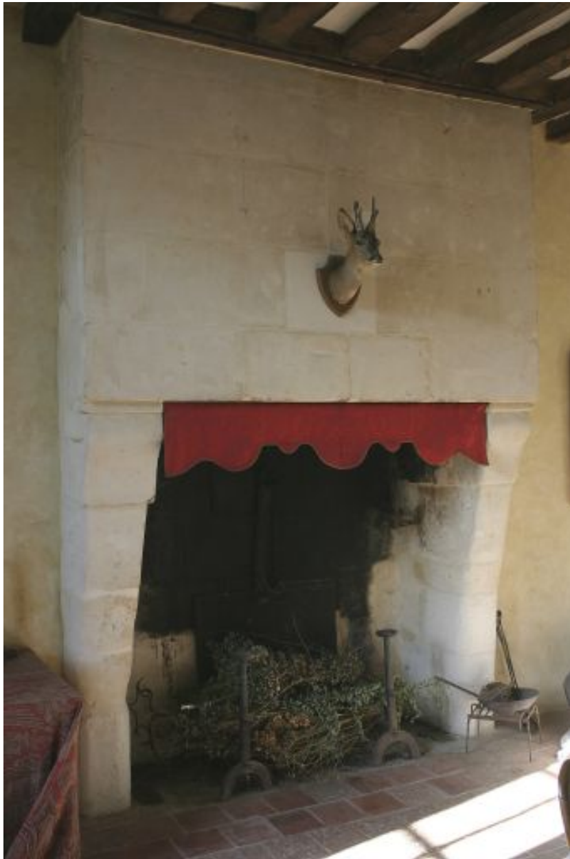
Salle ouest au rez-de-chaussée : cheminée.
