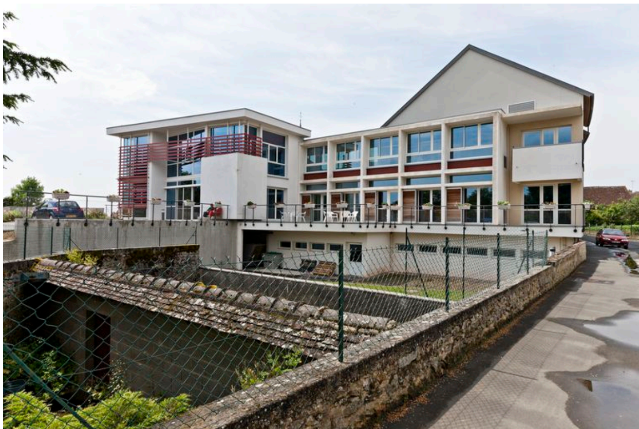
Elévation sud de l'EHPAD.
