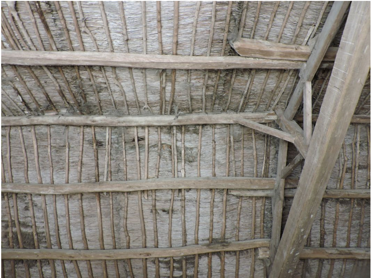
Le toit du hangar, en roseau.
