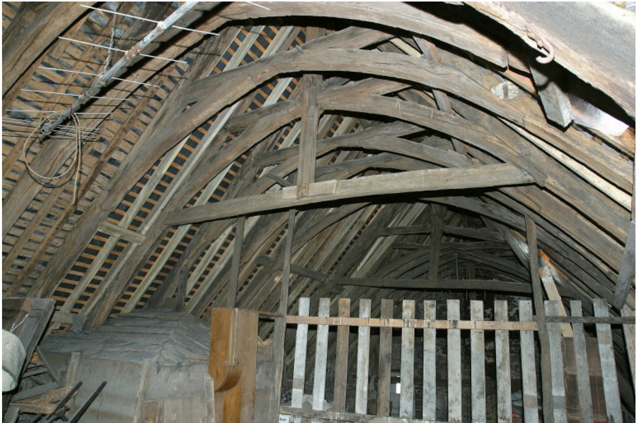
Comble : la charpente vue depuis le sud-est.
