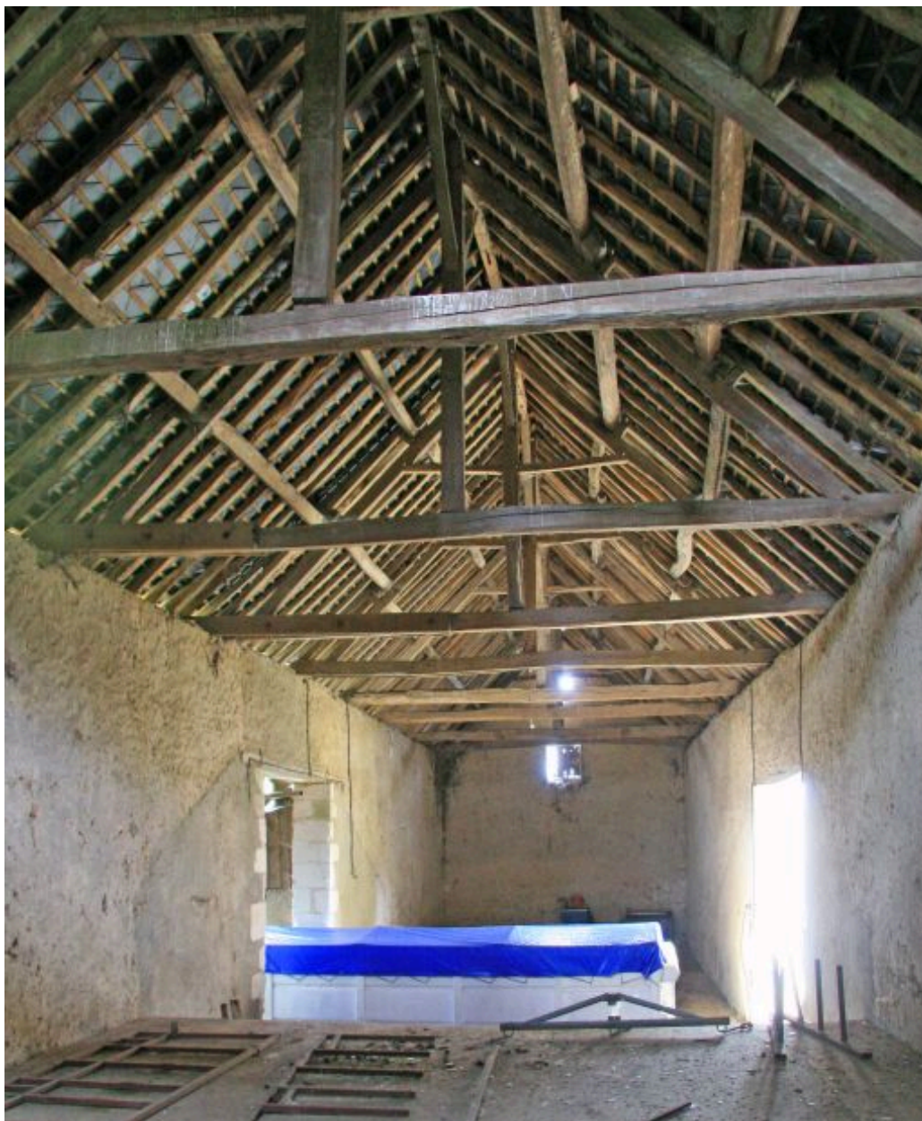
La grange, intérieur : grande nef couverte d'une charpente à pannes.
