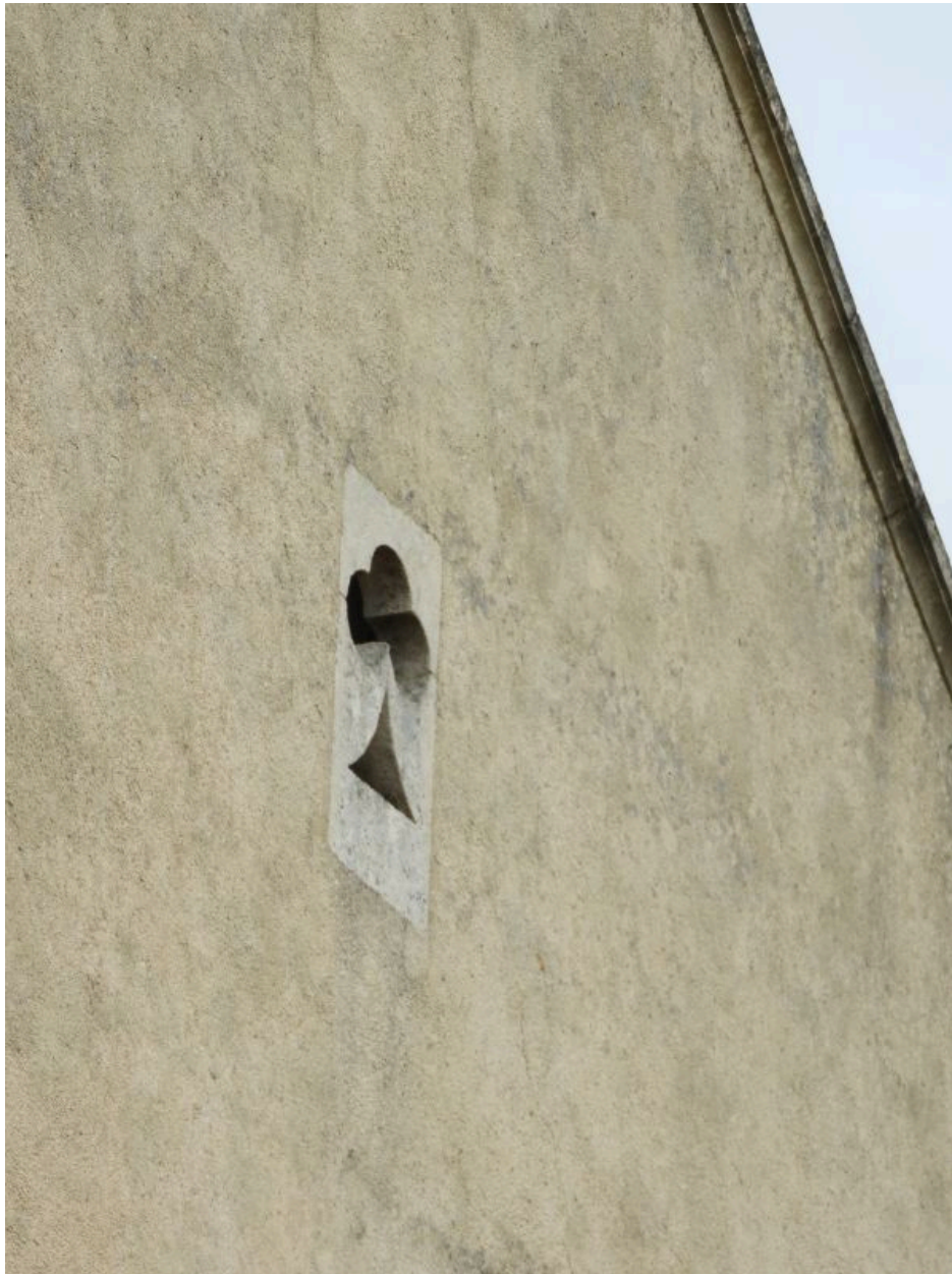
L'as de trèfle percé dans le mur pignon sud.
