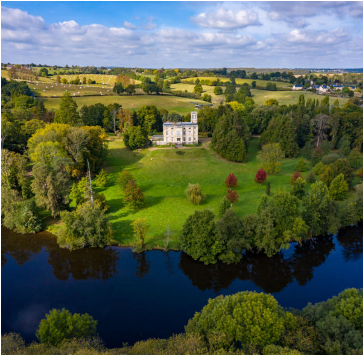
Une vue aérienne du château et de son parc, depuis l'est.
