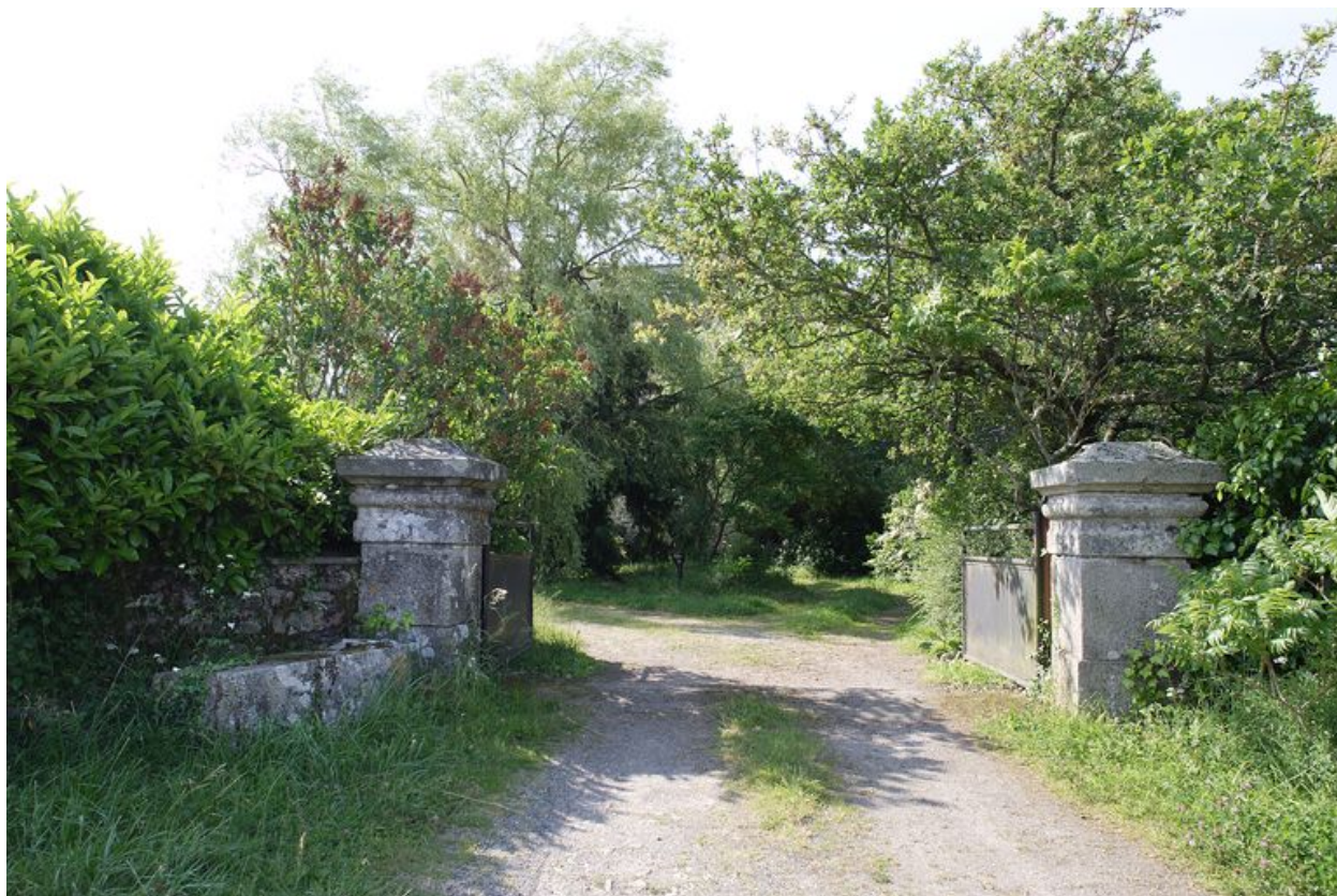
L'entrée de la cour du presbytère vue depuis la route au nord.
