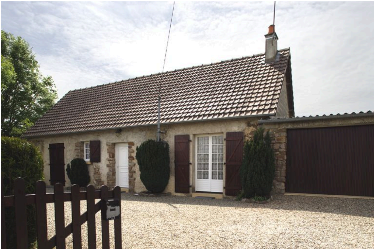
Le logis-étable ouest vu depuis l'est.
