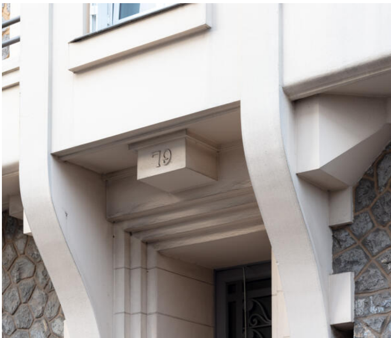
Détail du linteau de la porte.
