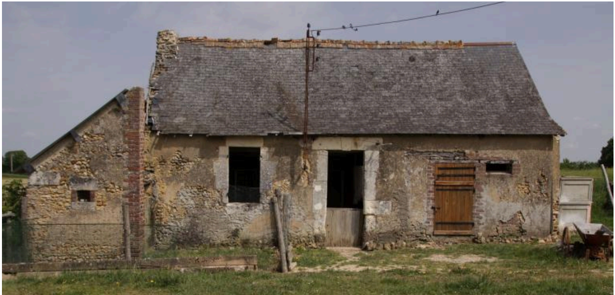
Maison 1 : façade sur cour.
