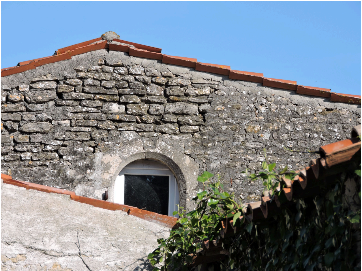
La baie en arc en plein cintre sur le mur pignon sud de la maison.
