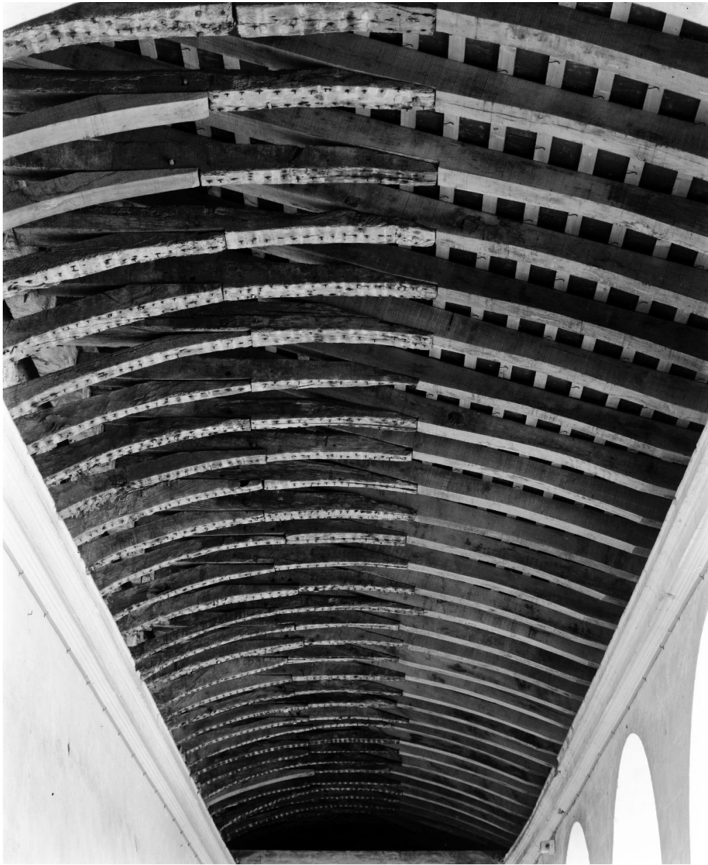
Galerie nord du cloître : vue d'ensemble du couvrement, d'ouest en est.
