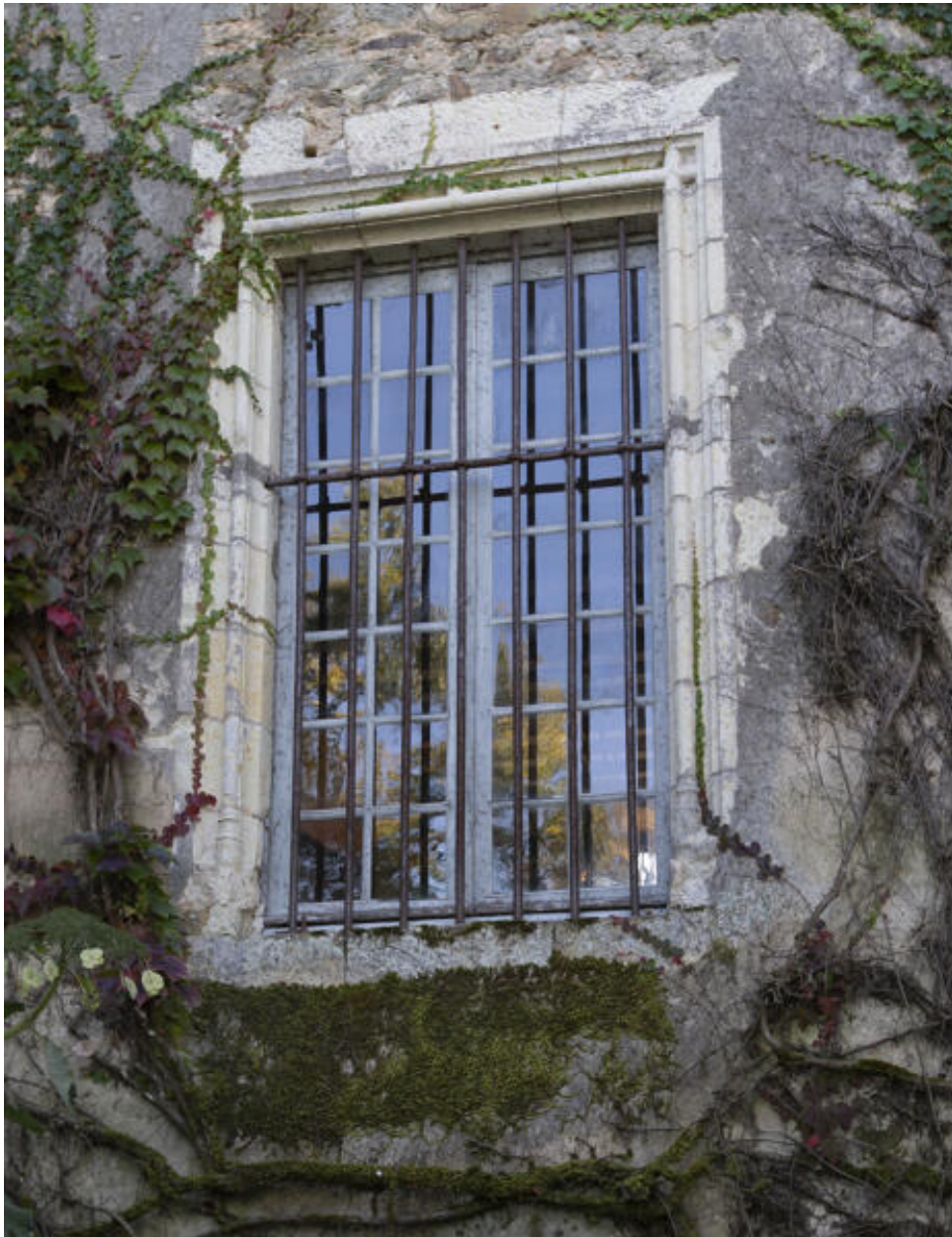
Une fenêtre à moulures croisées sur l'élévation postérieure.
