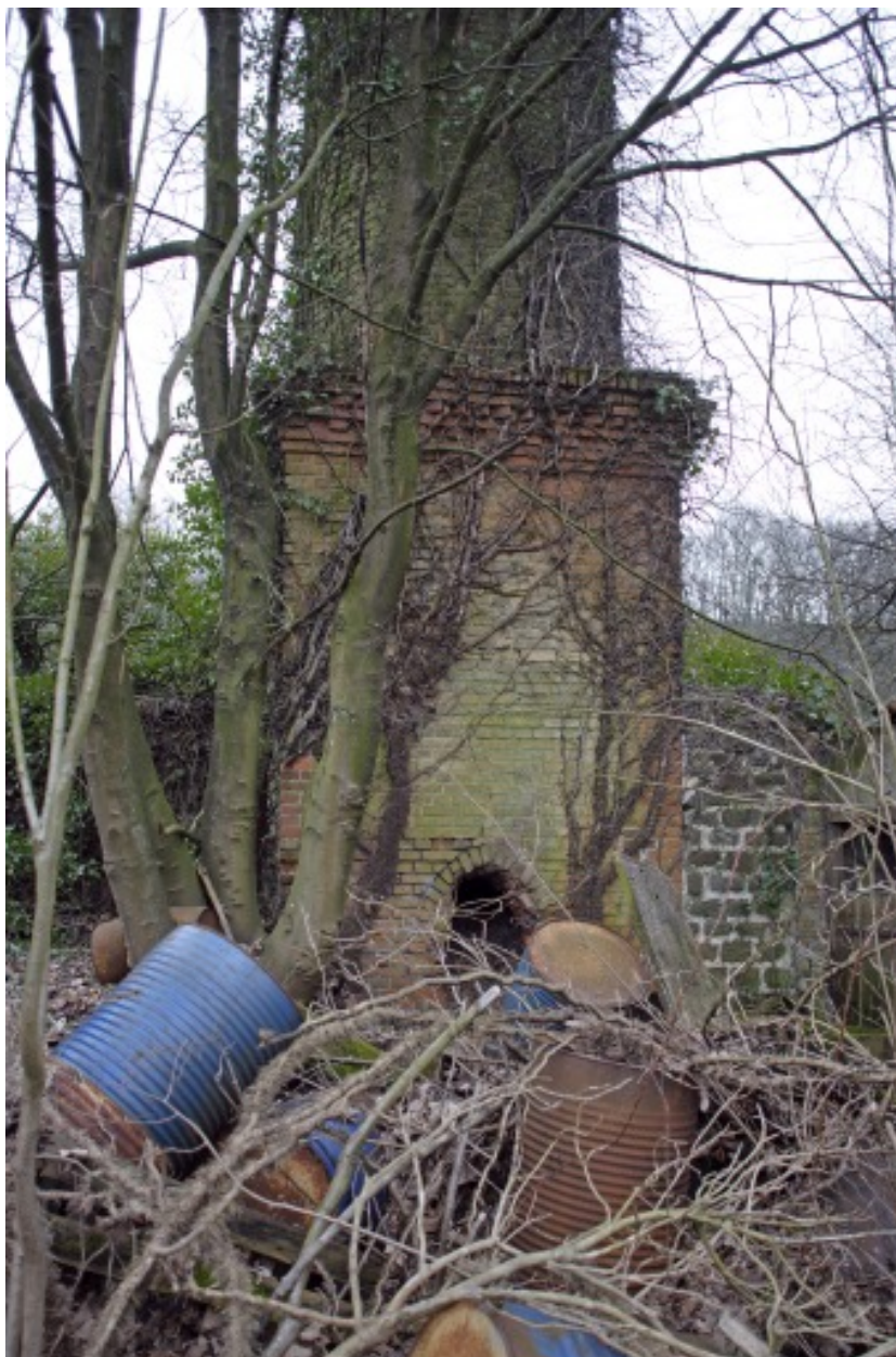
La base de la cheminée vue depuis l'ouest.
