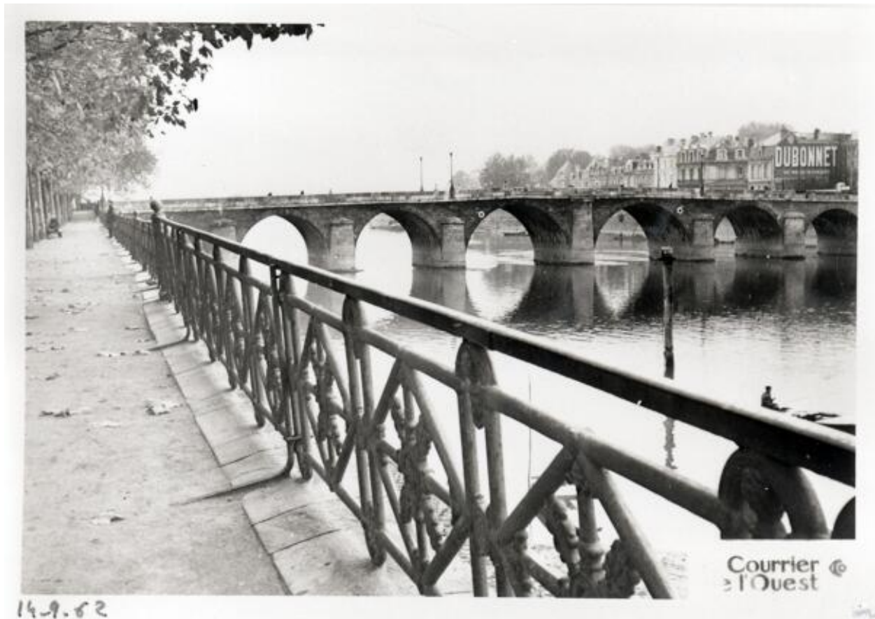
Vue d'ensemble du pont en aval depuis la rive gauche, avant la création de la voie express sur berge, fotogr., du Courrier de l'Ouest, 1962. (Coll. part. Michel Lemesle).
