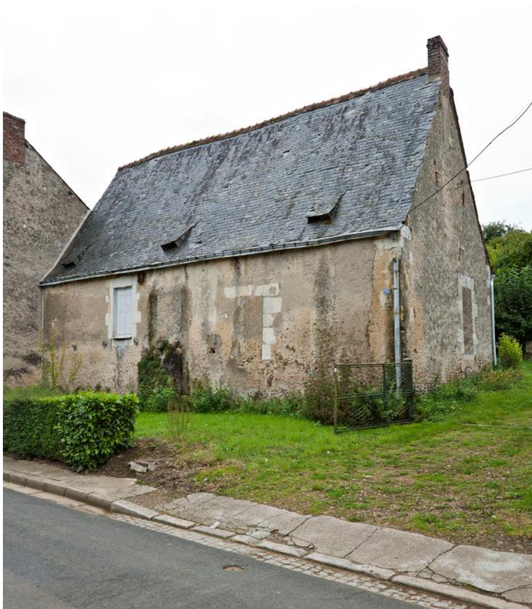
Vue de volume prise depuis la rue.
