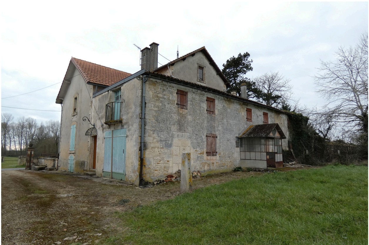
Le corps de bâtiment à l'arrière du logis vu depuis le nord-est.
