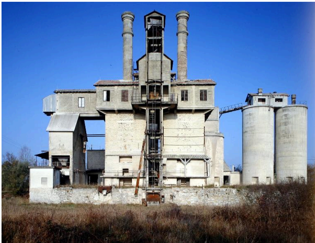
Usine de chaux : façade sud sur les fours et le skip
