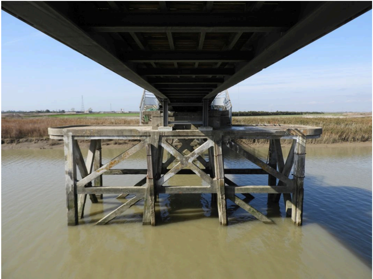
VUE sous la passerelle de 2012, en direction de l'ouest.
