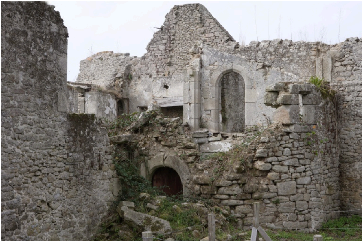
Logis. Vue de la tour d'escalier.
