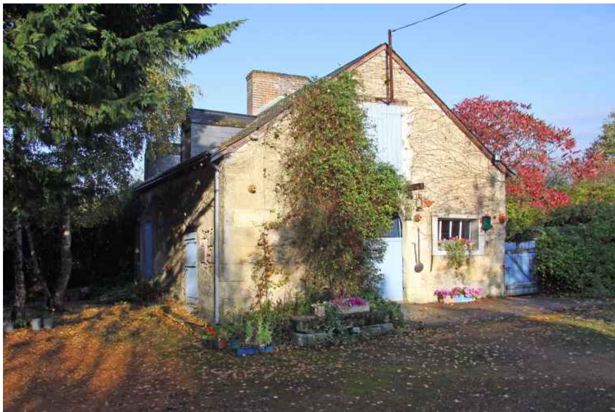
La ferme du château, petit bâtiment remanié en porcherie.
