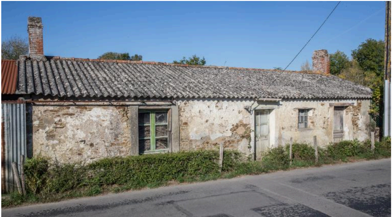
Maison, 2 route de La Chauffetière.
