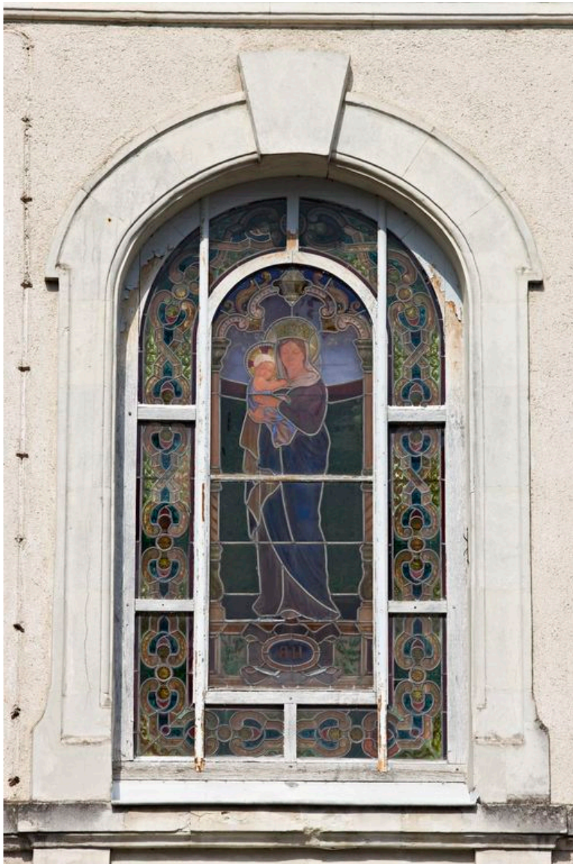
Façade antérieure, 1er étage, baie axiale ornée d'un vitrail.
