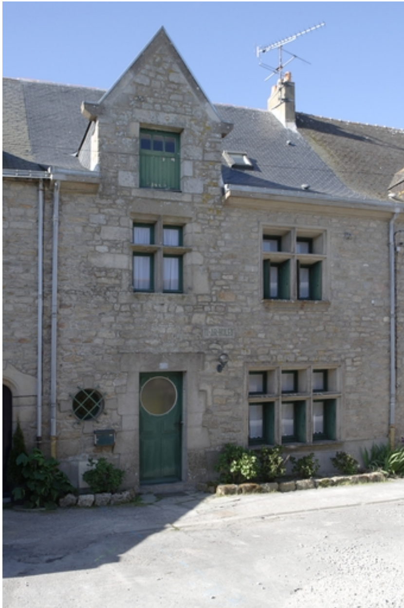
Vue de la maison n° 6 rue du Four dite Ti ar holan.
