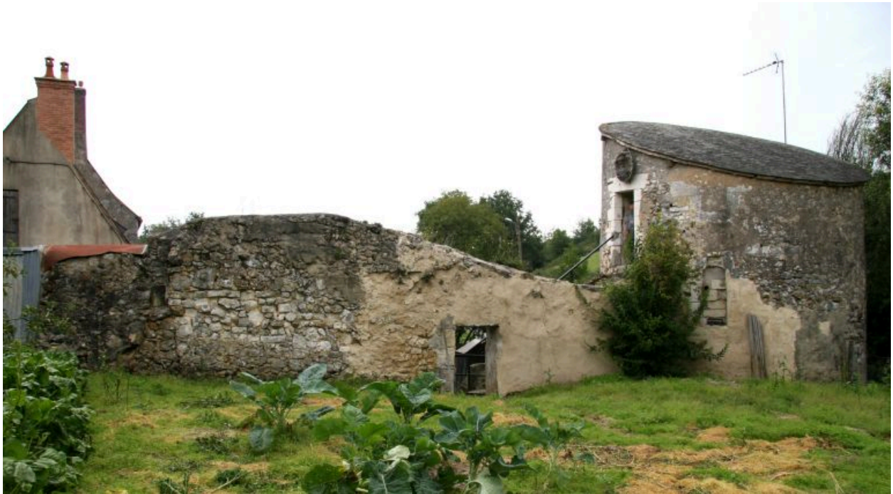
Vue d'ensemble prise de l'ouest : mur d'enceinte attaché à la tourelle.
