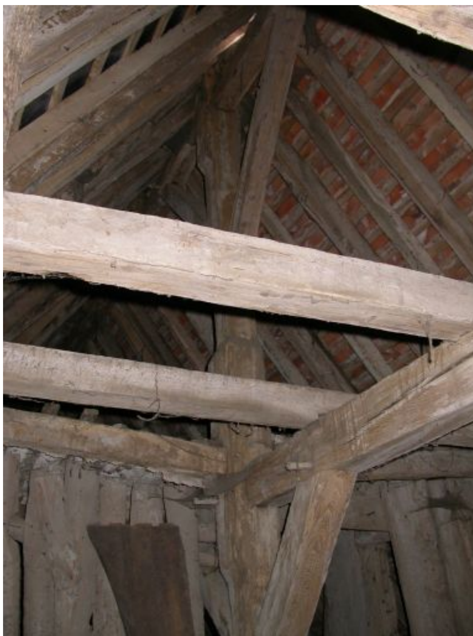
Charpente avec sous-faîtage.
