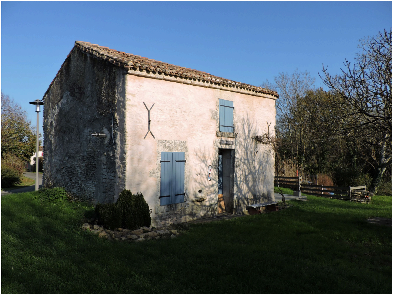
Le logis vu depuis le sud-ouest.
