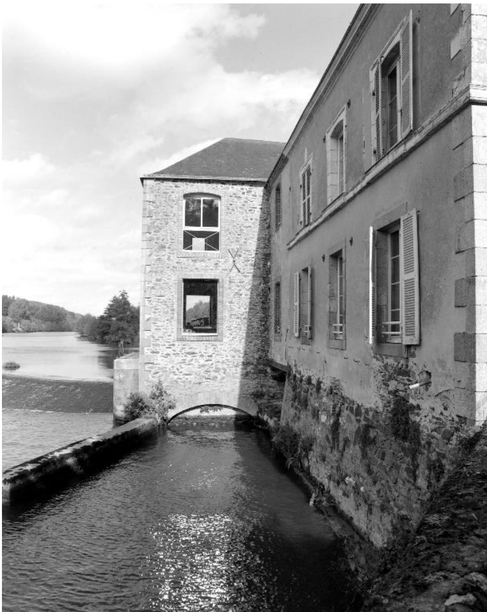
Le canal de fuite du moulin, vu du sud. Façade sud du moulin et façade ouest du logement du meunier.
